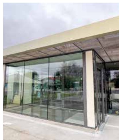
Le nouveau sas d'entrée de l'Espace aquatique
